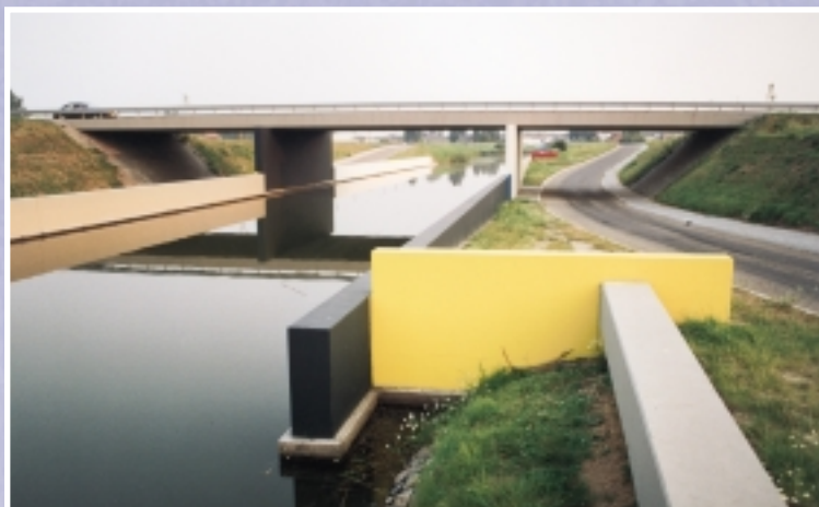
De Provincie Zuid-Holland was opdrachtgever voor de brug over de Dirkslandse vaart S47, welke rondweg loopt langs Middelharnis, Sommeldijk en Dirksland. De brug symboliseert hoe door middel van kunst een weg ingepast kan worden in het landschap. De brug is één van de belangrijkste elementen in dit project. Ontworpen en gerealiseerd 1984/1989.
